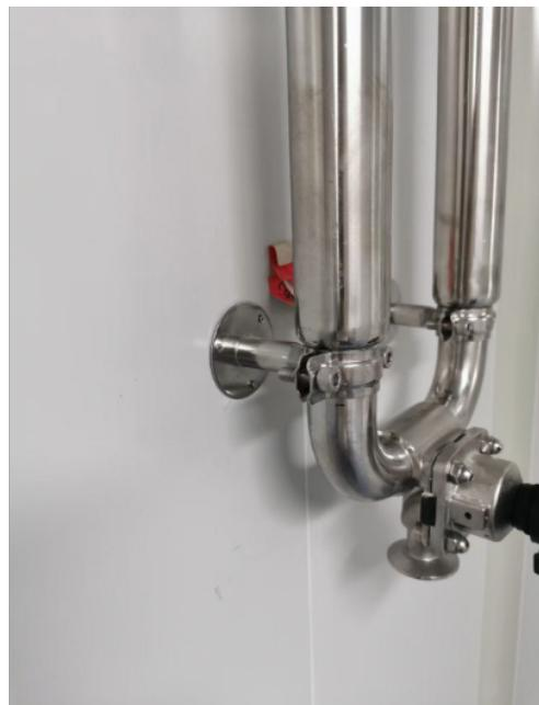
洁净管道施工准备注意事项：机具准备方面，施工机械、工具在使用前需进行检查，并彻底清洗，表面不得有油污与其他脏物。同时，待用材料非到用时不得拆封与去除标识。特别注意的是，焊接气与保护气的纯度满足较小纯度为99.999%以上，如果气源达不到要求，要进行二次过滤。作业环境准备方面，施工场地应彻底清扫干净，并铺设无尘的橡胶板或纸板。在作业期间每日应清理废旧料并用吸尘机或湿净拖畚清洁1~2次；在进行卫生级配管作业时不得进行非不锈钢作业，同时严禁将碳钢材料与附有油脂类的工具带入现场；进入现场，必须穿戴清洁工作服、胶鞋与软质帽子。洁净管道一般普遍应用于制药行业。常州正规洁净管道多少钱
