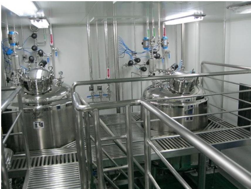
**GMP洁净管道设计：**不管是进行任何洁净管道施工，都要先确认好施工图纸，同时召集相关的施工设计、质量管理、验证、生产人员来进行研究，所设计出的施工图纸能不能达到GMP的规范要求、能不能满足使用者的需求。在设计空调系统时，要包括洁净级别、风机压头、温度湿度、换气次数以及不同区域压差等。而洁净管道的注射水和纯水设备要能防止污染以及滋生微生物，输送管和贮罐的材料要耐腐蚀、无毒，并且要对其进行定期的清洗灭菌，在进行管道设计安装的时候，要避免盲管和死角。
